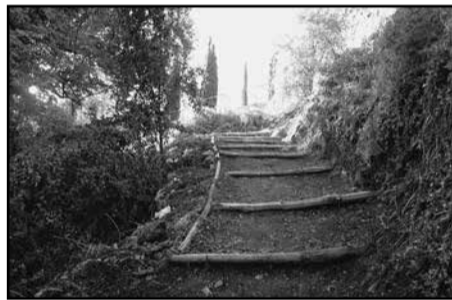
Παρεμβάσεις με κορμούς δέντρων στην πρόσβαση που ανοιχθηκε με το μηχάνημα
